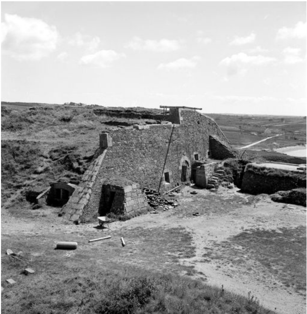
Vue des lignes de Quéléren en 1969 : extrémité droite des lignes, flanc droit de la contrescarpe du bastion n° 1 avec entrée des casemates
