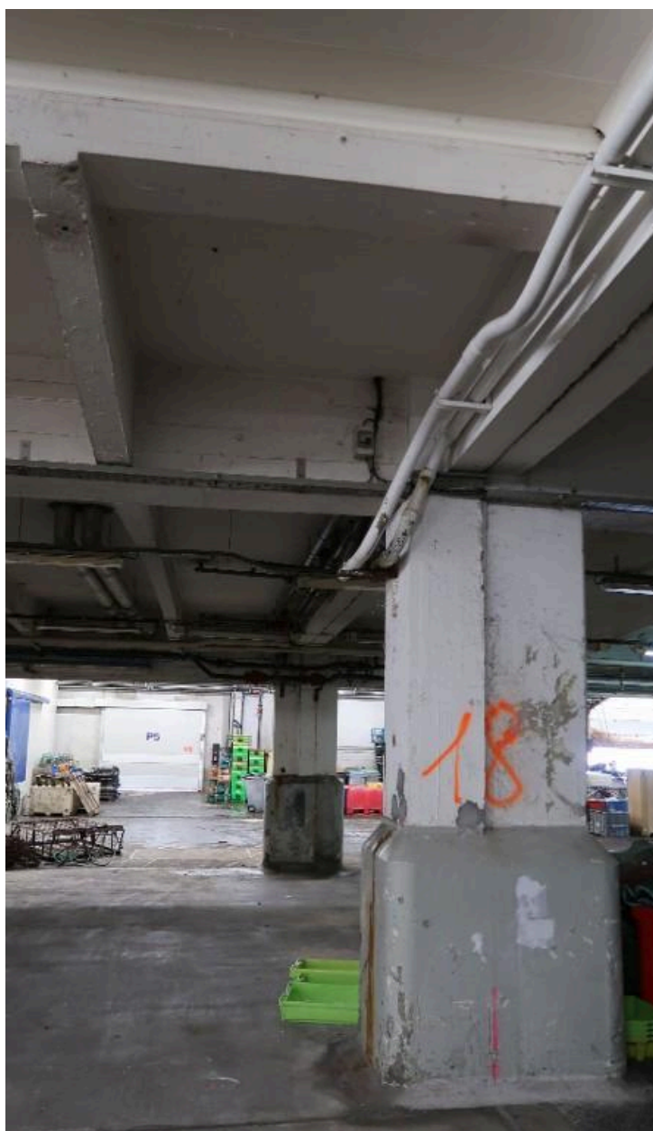
Criée de Concarneau : vue intérieure, pilier 18, limite de concession et de propriété
