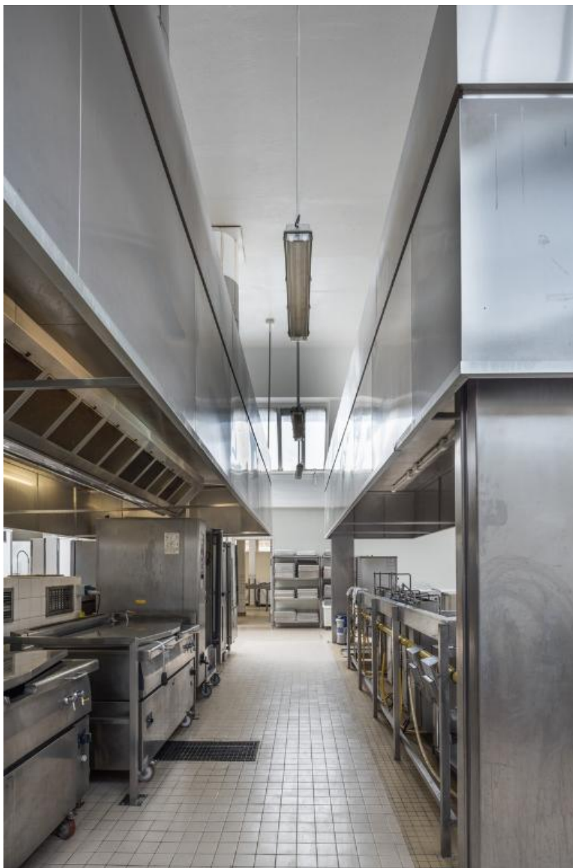
Vue intérieure des cuisines.
