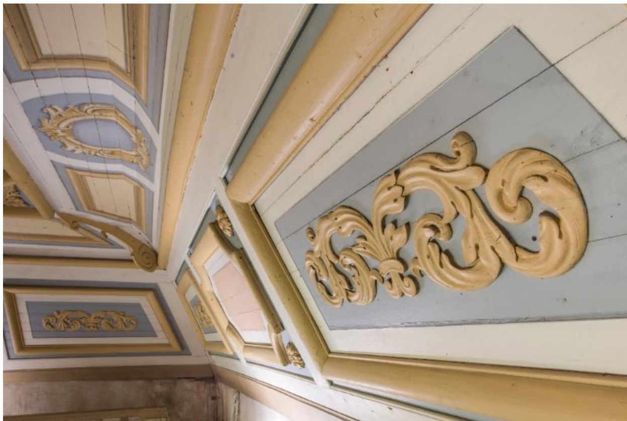
Escalier monumental, départ du plafond: détail des moulurations et des rinceaux sculptés
