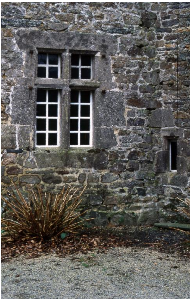
Vue ouest, détail fenêtre.
