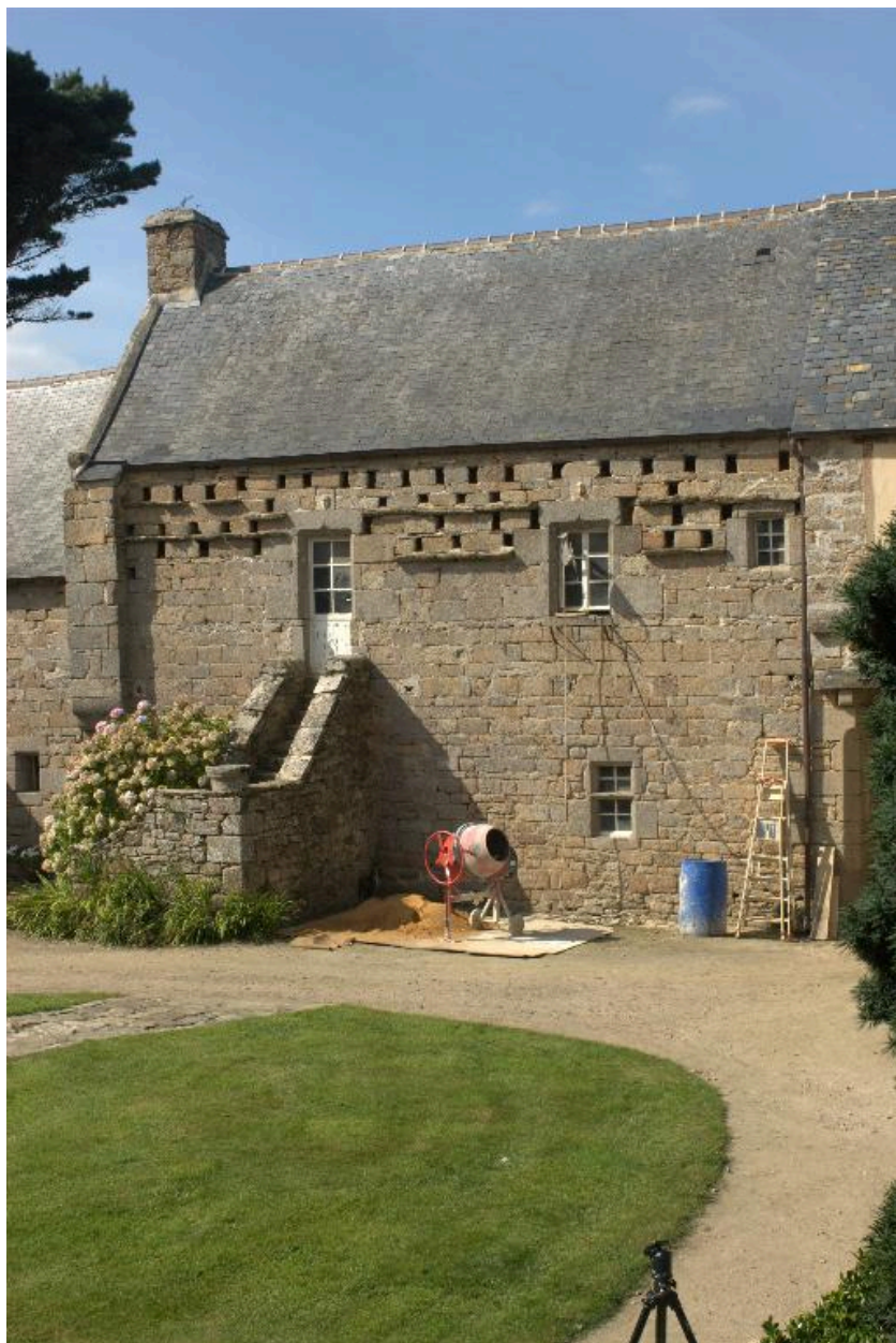
Vue de la façade est depuis la cour intérieure
