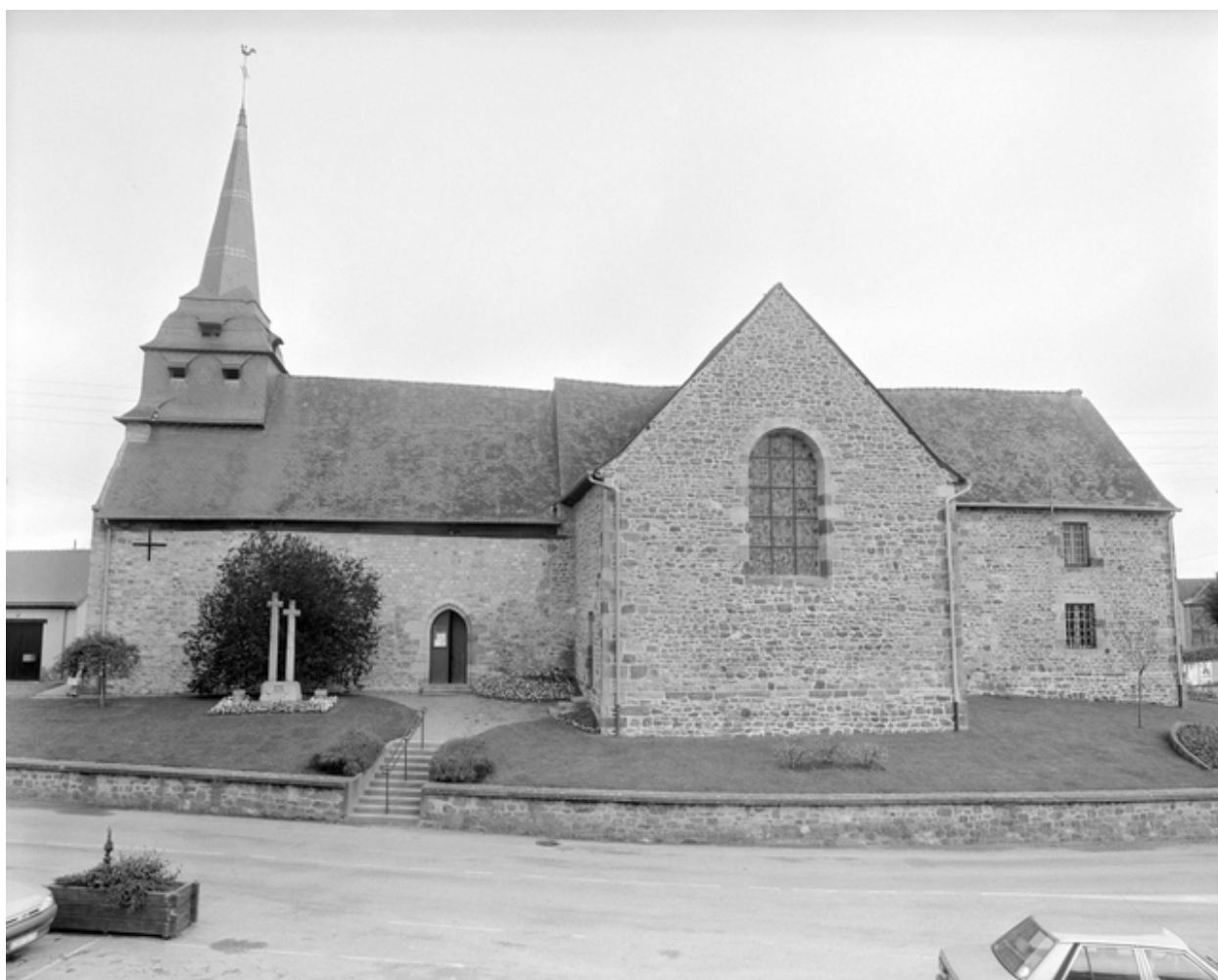
Elévation Nord : vue générale
