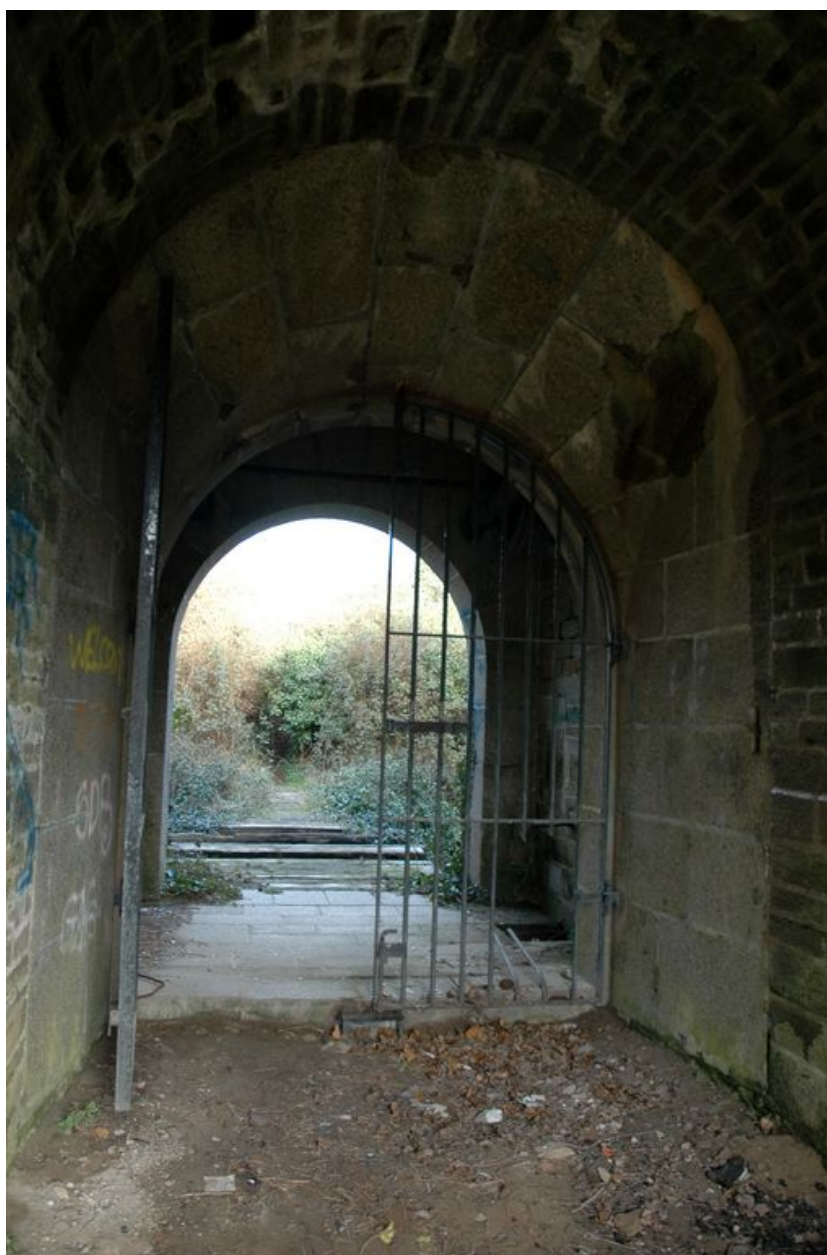
Vue du passage d'entrée voûté en berceau et de la grille fermant l'accès à la redoute (état en 2006)
