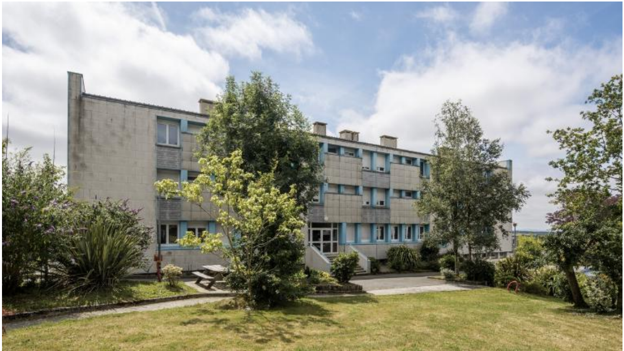
Administration, façade nord. Péron et Weisbein, architectes, 1967-1968.
