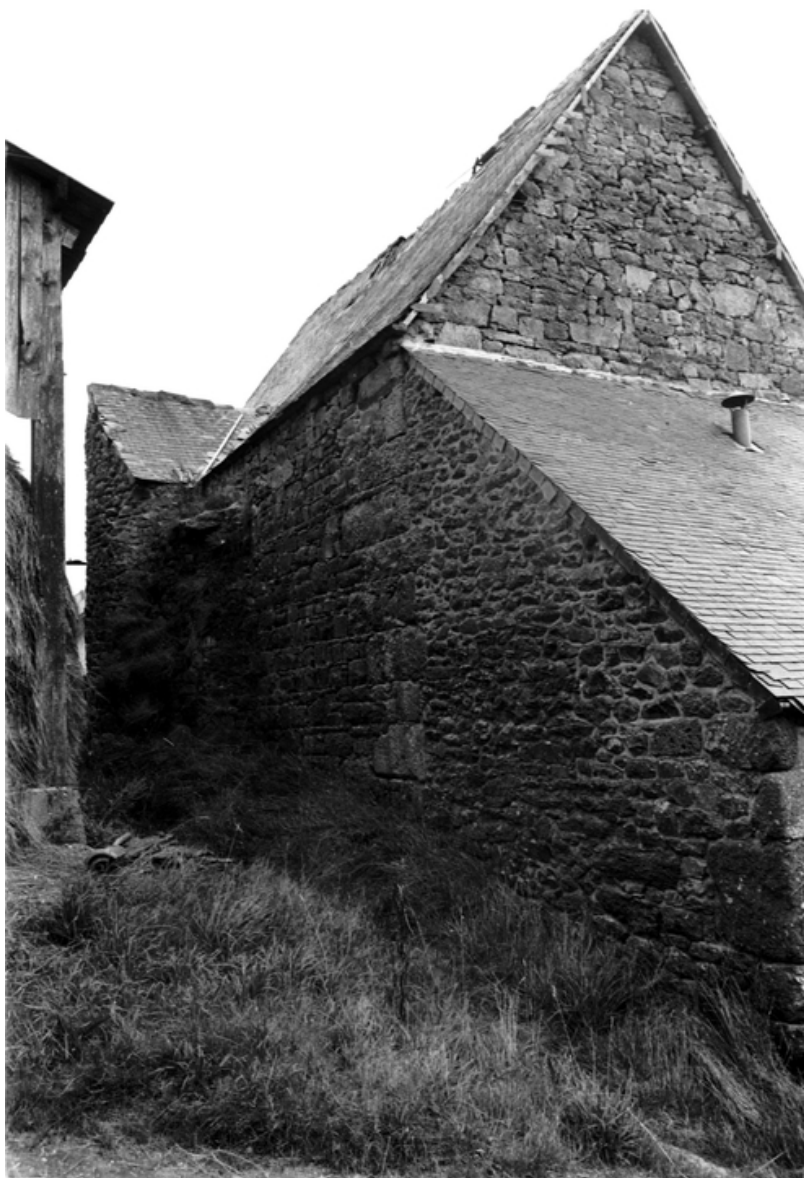
Maison (Kéravel) : vue nord-ouest
