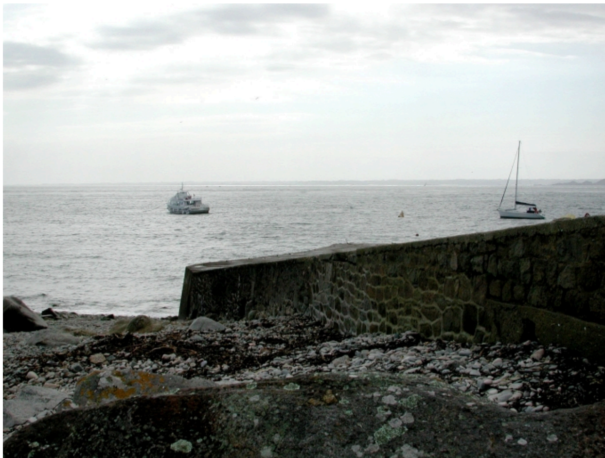
Vue du mur du quai côté est : revêtement en moellons de granite
