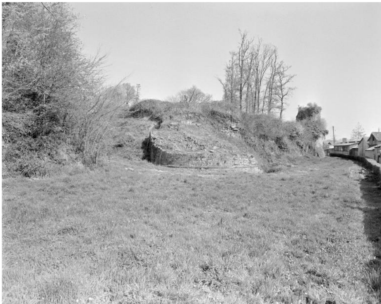
Vue générale depuis le sud (état en 1995)
