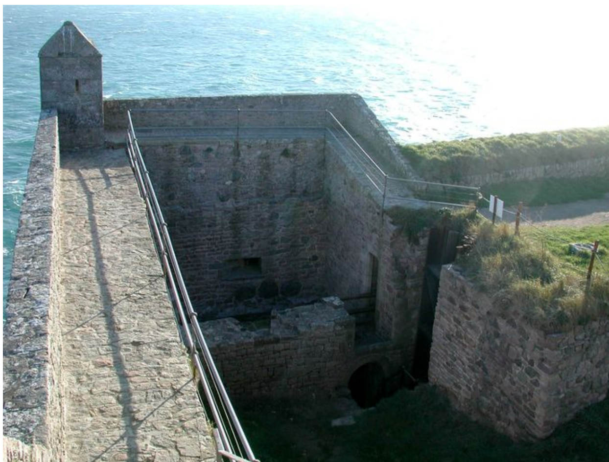
Vue du Fort La Latte
