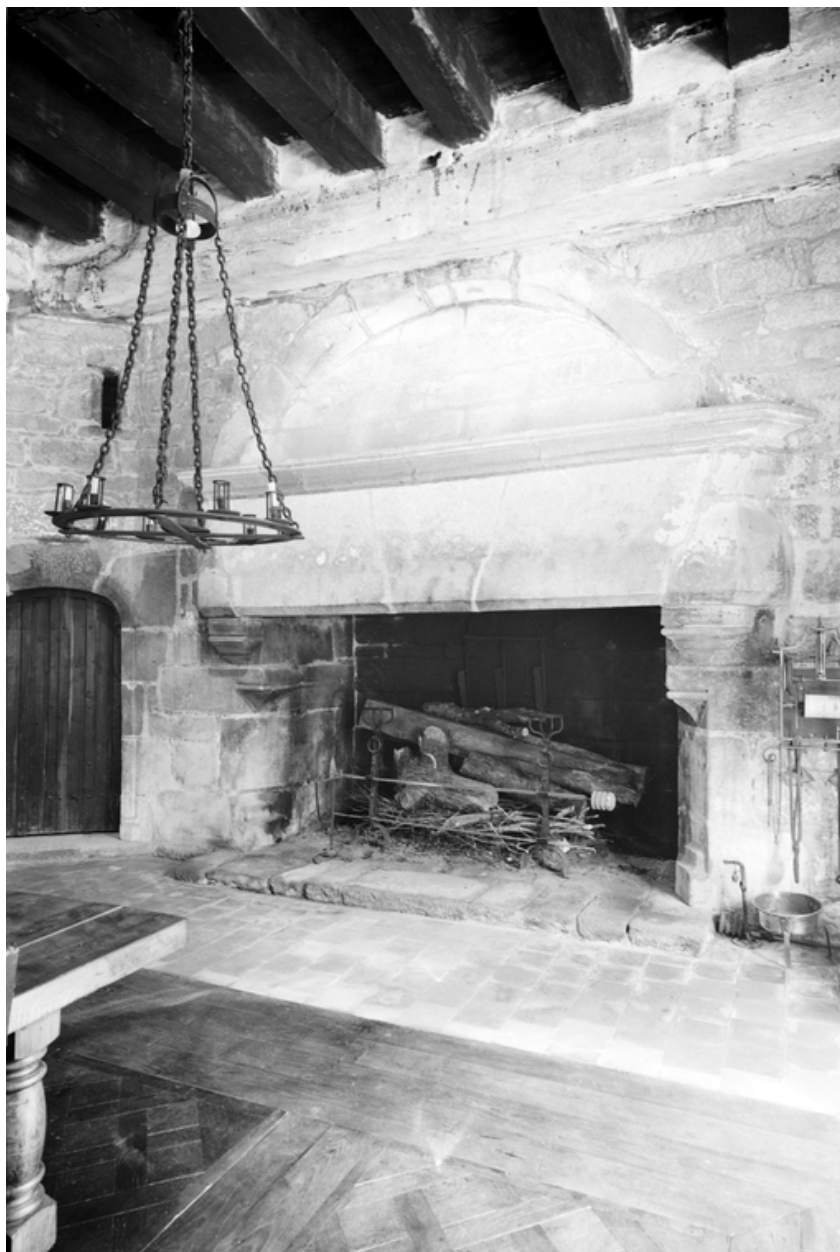
Logis, rez-de-chaussée, salle à manger nord : cheminée
