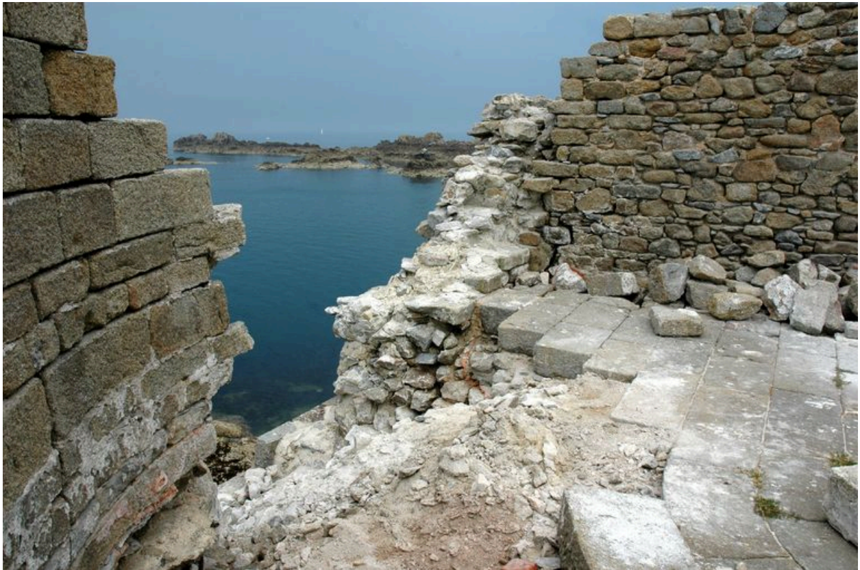
Vue du fort de la Conchée : parapet sud et dallage de la terrasse en cours de restauration
