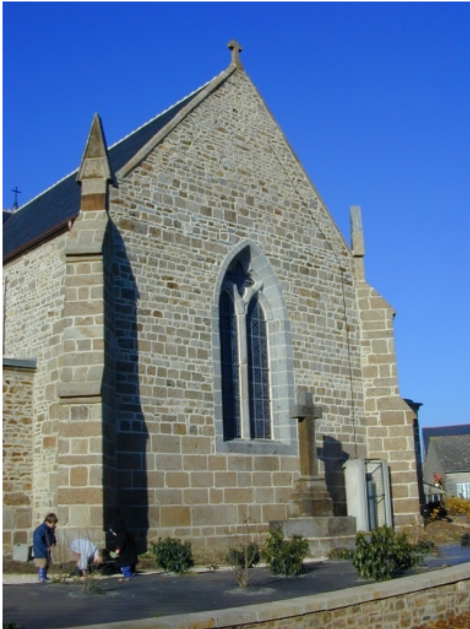
Le chevet : vue générale sud-est
