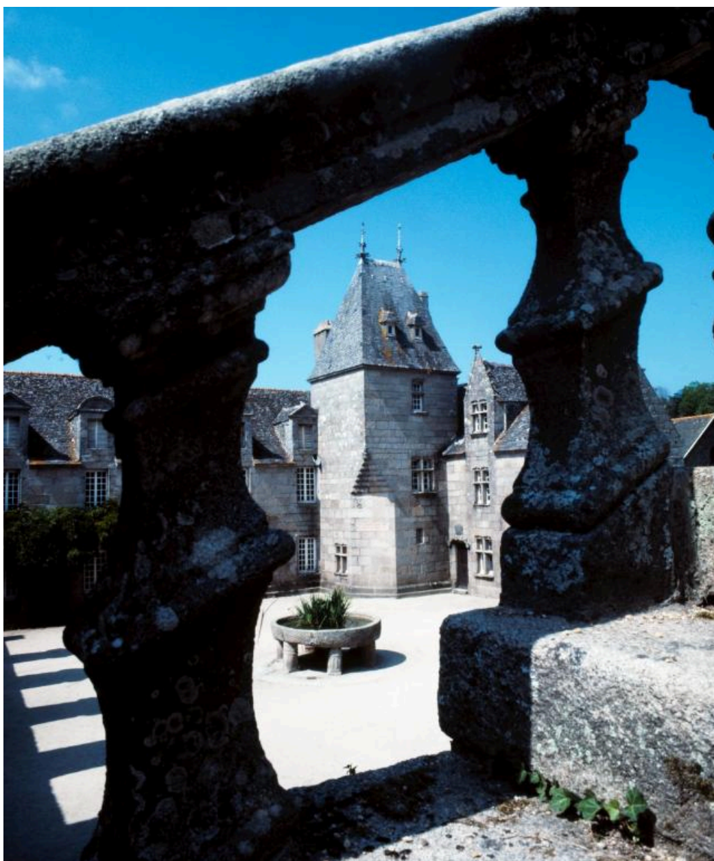
Logis, tour d'angle et balustrades de l'escalier
