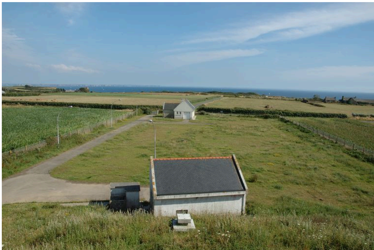
Vue du panorama depuis le poste de direction de tir vers le sud
