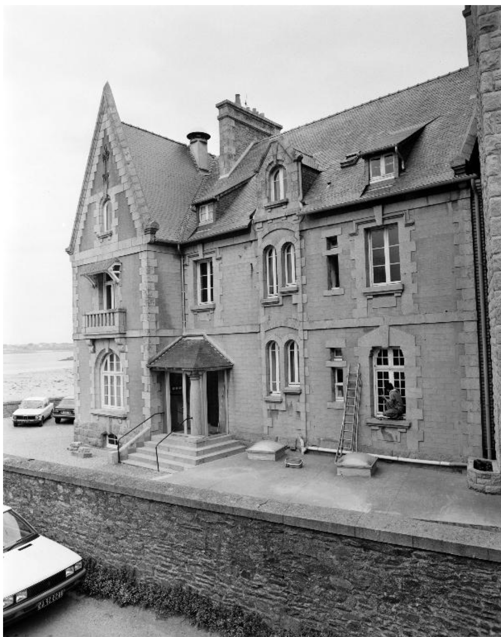
2 avenue Victor Hugo, élévation est, vue générale
