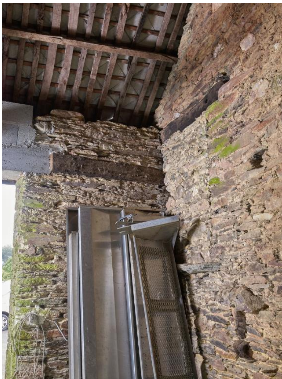
Logis 1706. Pignon nord du logis et dépendance transformée en remise. Porte de communication bouchée entre la chambre de l'étage et la dépendance
