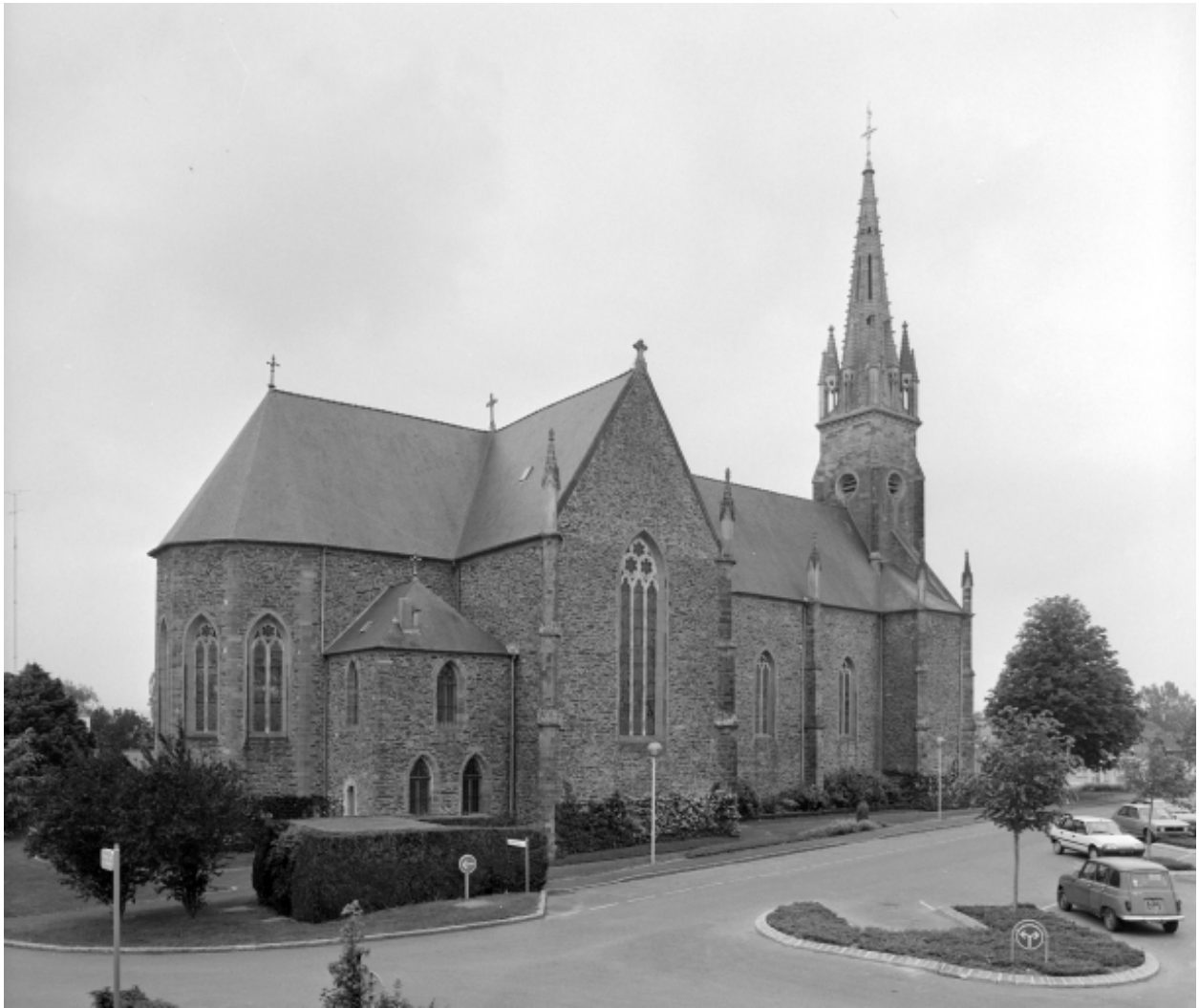
Elévation Nord-Est : vue générale
