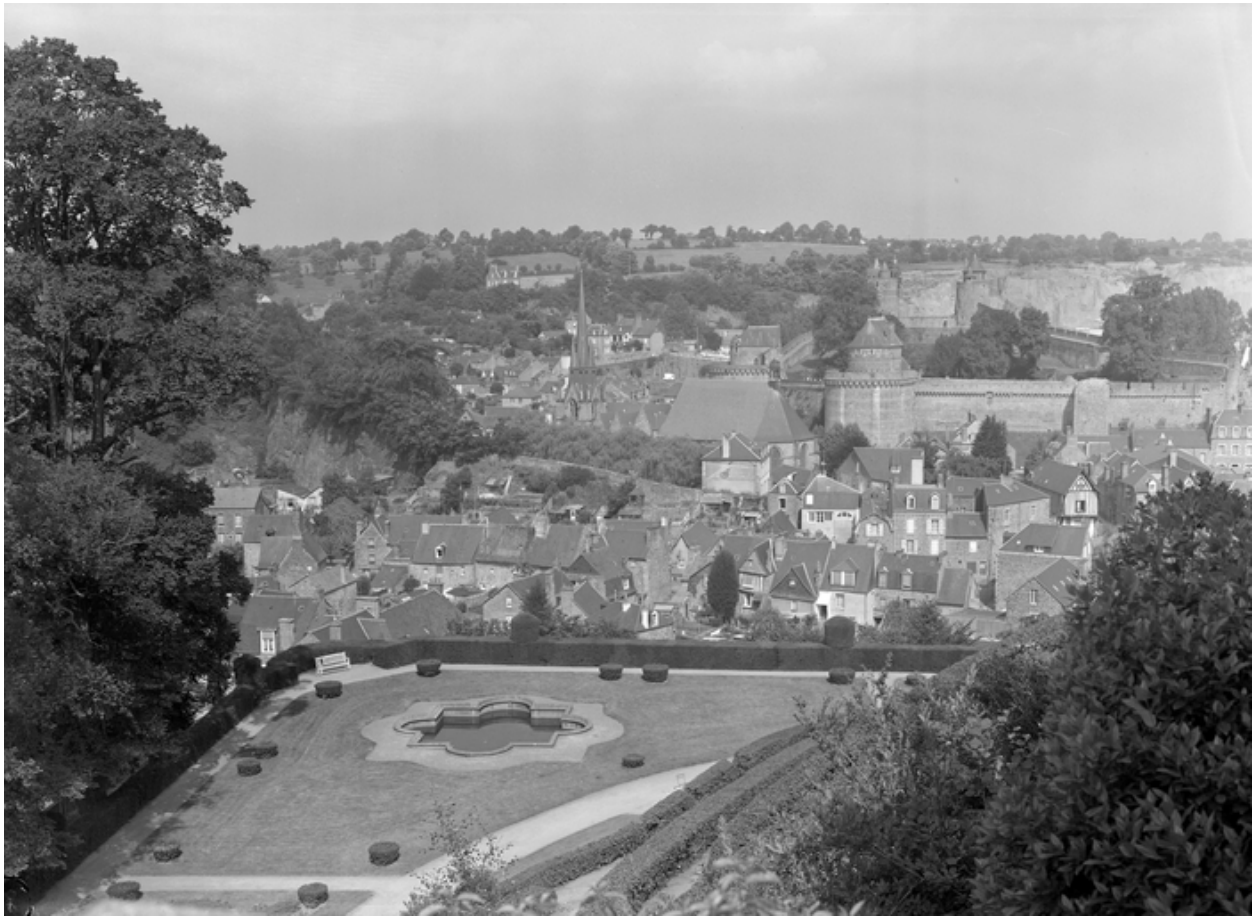
Ville Basse, église Saint Sulpice et château, vue prise du sud.
