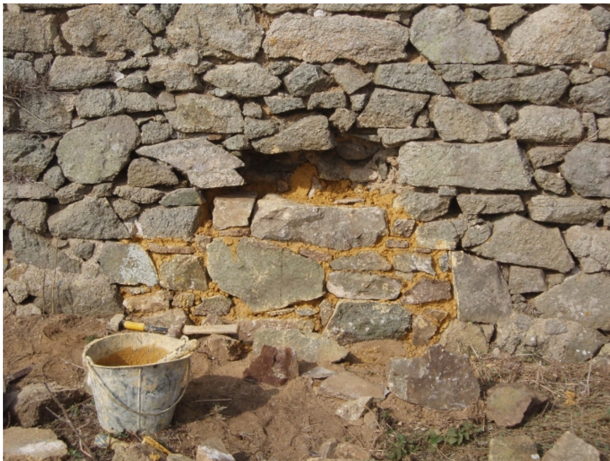
Mur percé en cours de restauration (collection particulière)
