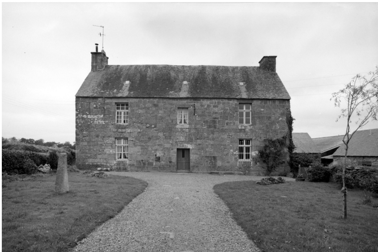
Façade sud du logis
