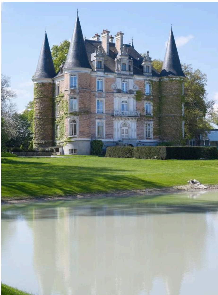
Vue biaise de la façade nord
