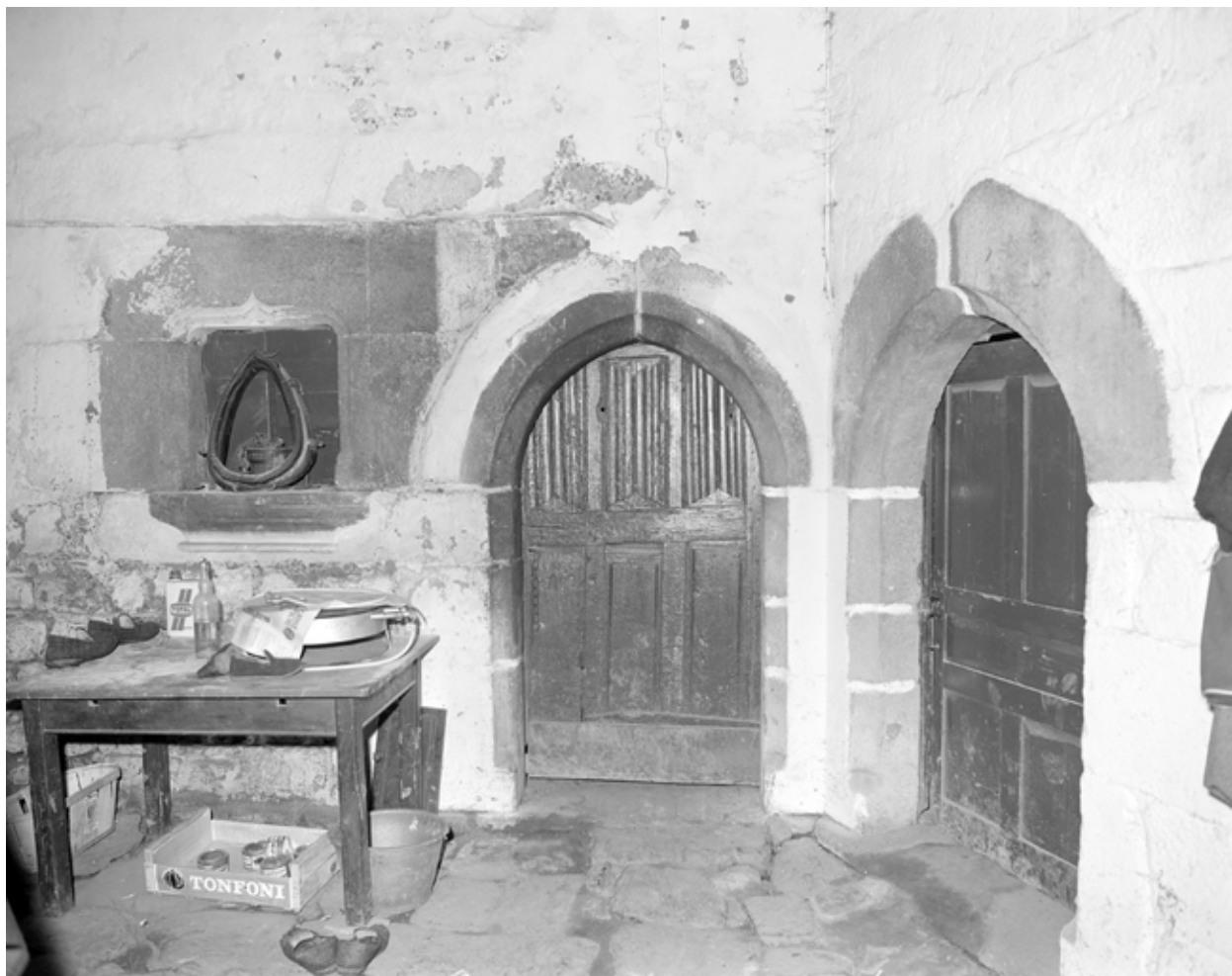
Porte de communication du rez-de-chaussée
