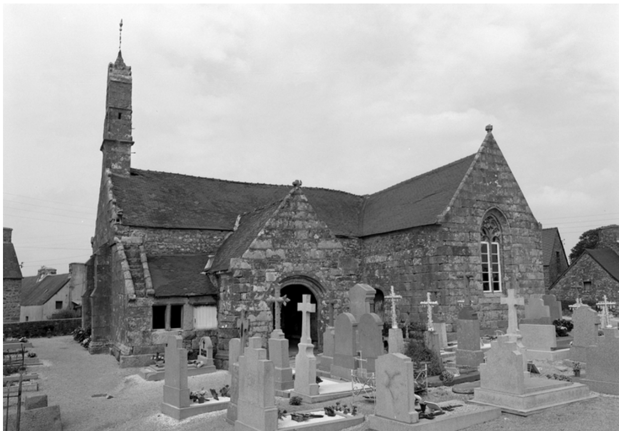
Vue générale de l'élévation sud
