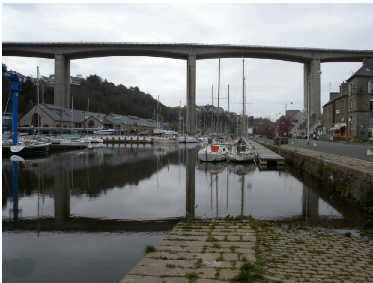
Vue de la cale amont du bassin à flot
