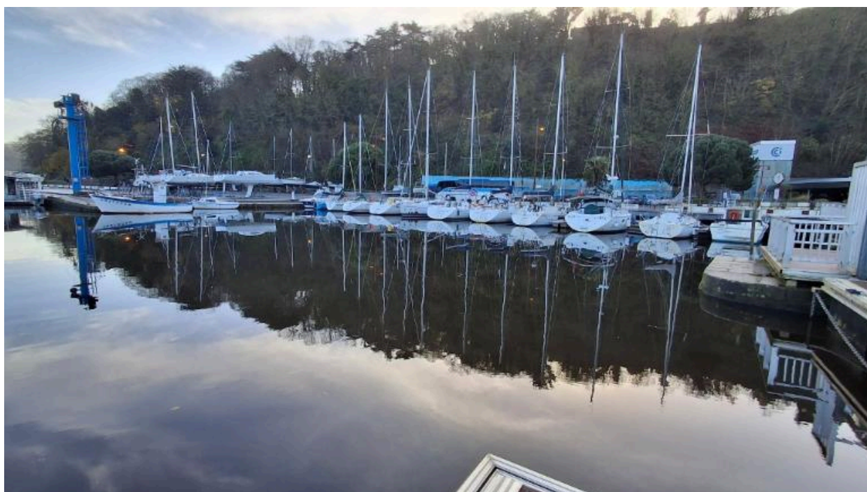
Ancienne aire d'évitage et ancien gril de carénage
