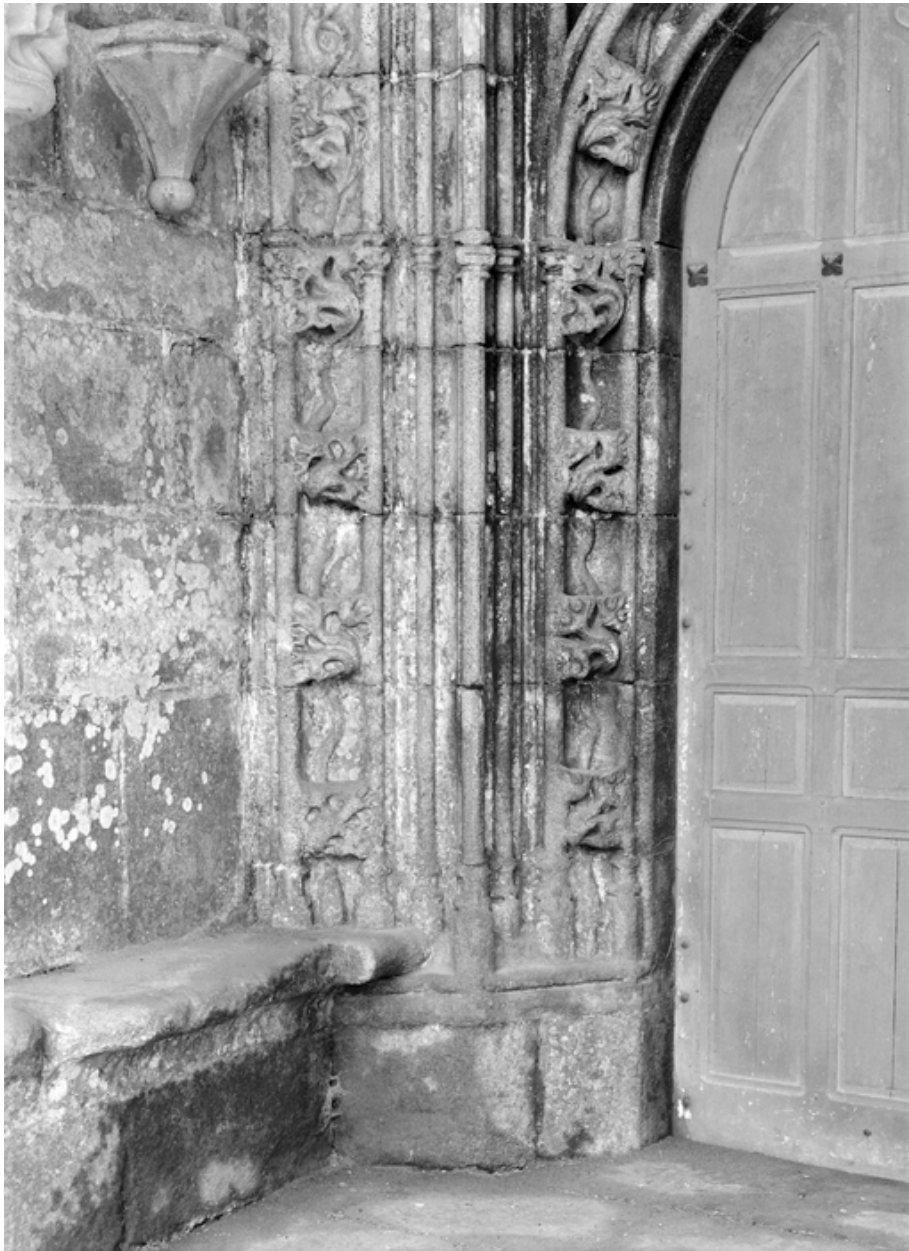
Portail du mur nord du porche sud, détail de l'ébrasement ouest.
