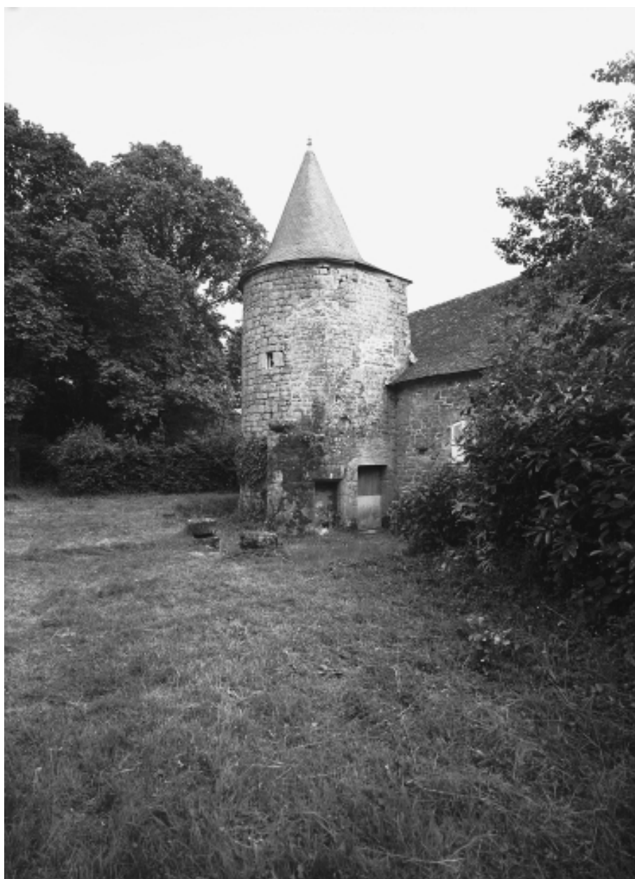
Tour d'escalier : vue générale nord ouest
