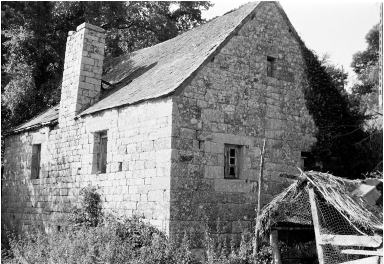
Vue de situation prise du sud
