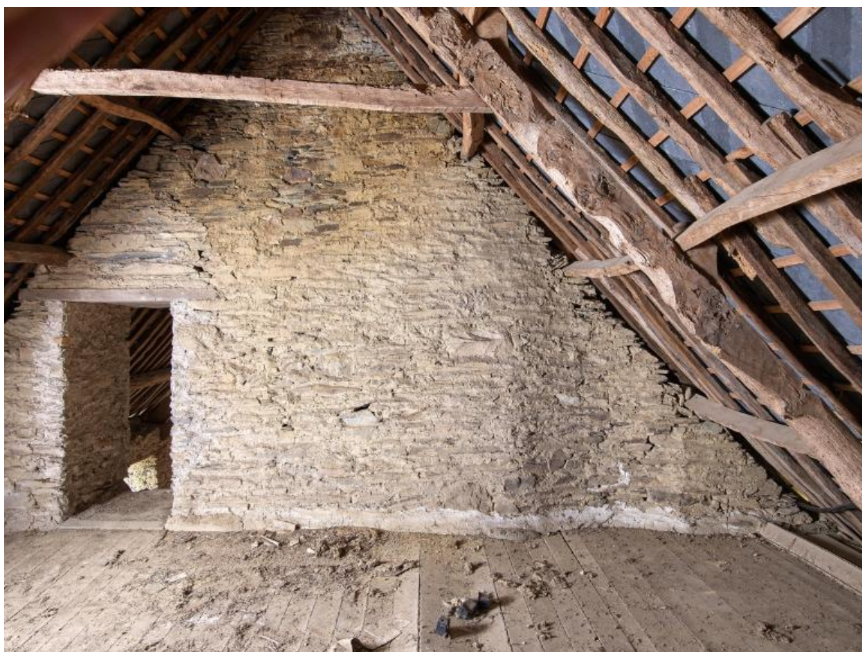
Logis 17e siècle. Comble au-dessus de la chambre à feu. Mur de refend avec porte et traces de l'ancien escalier à vis
