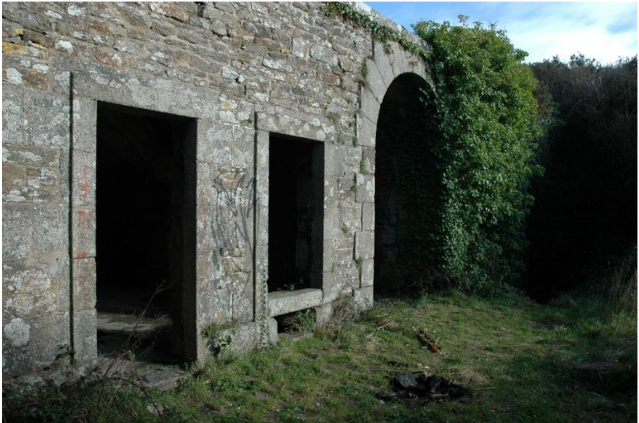
Vue des ouvertures de la chambrée de soldats nord et du passage d'entrée en arc plein cintre (état en 2006)
