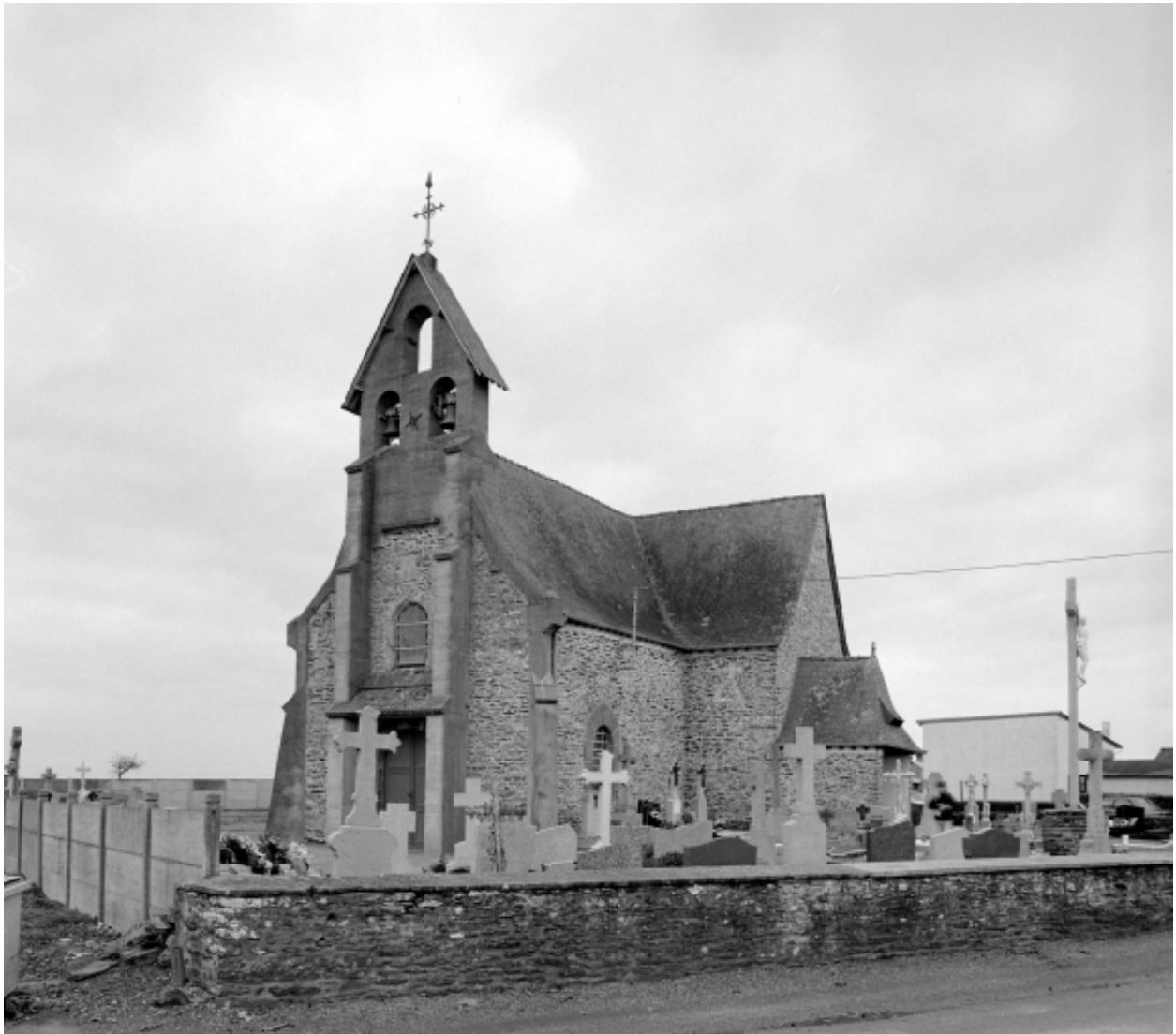
Elévation Sud-Ouest : vue générale
