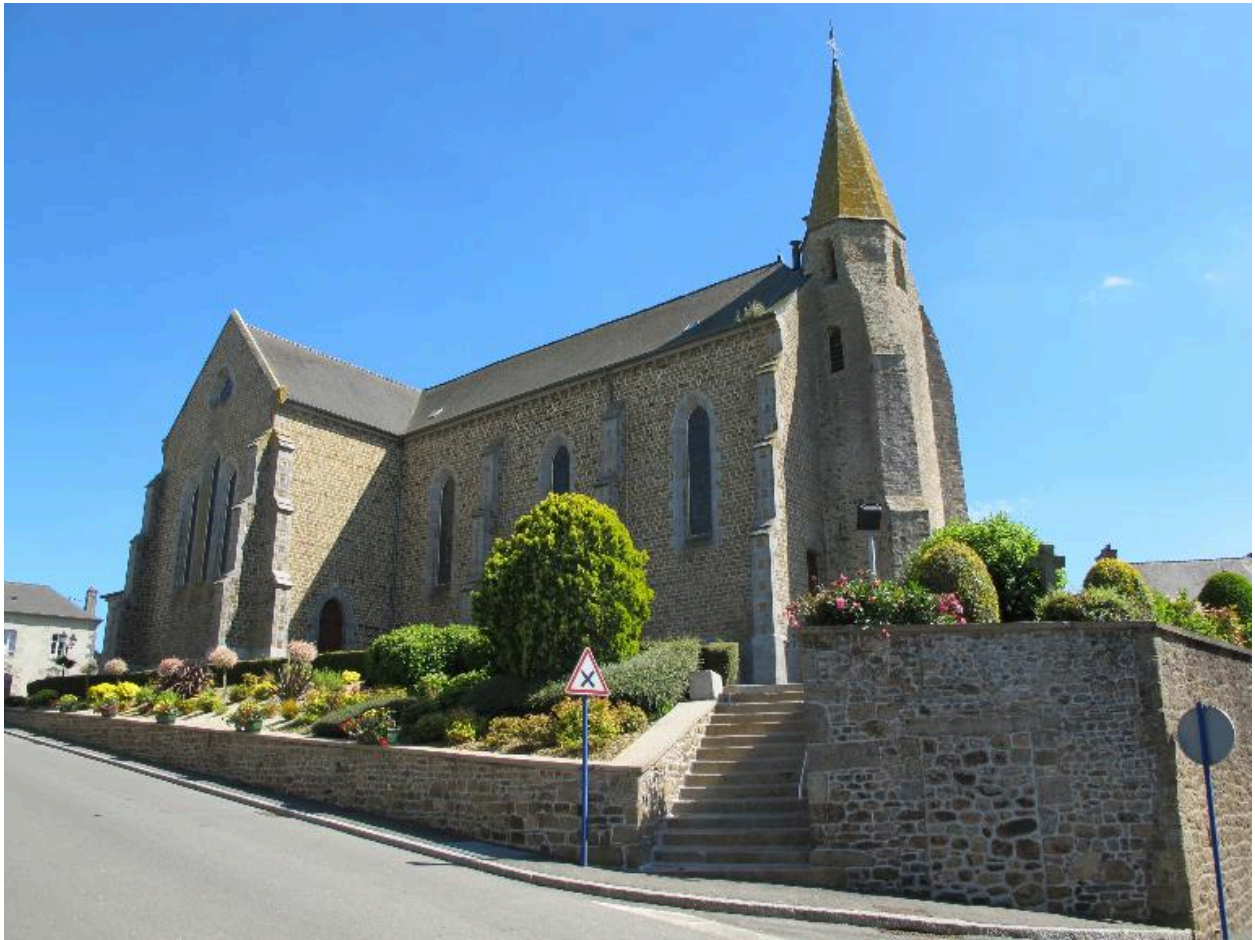
Vue générale : côté nord-ouest
