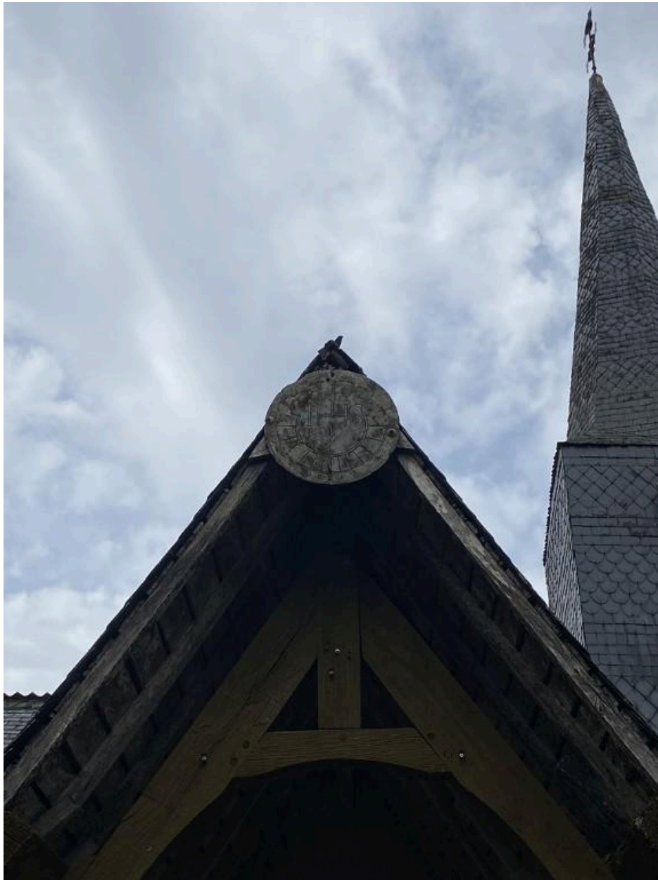
Porche sud, détail
