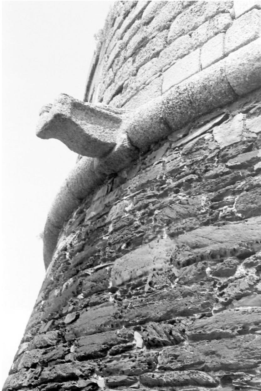
Vue de la batterie de Cornouaille en 1967 : extrémité ouest, escarpe, gargouille et cordon, chaînes harpées en pierres de taille de granite
