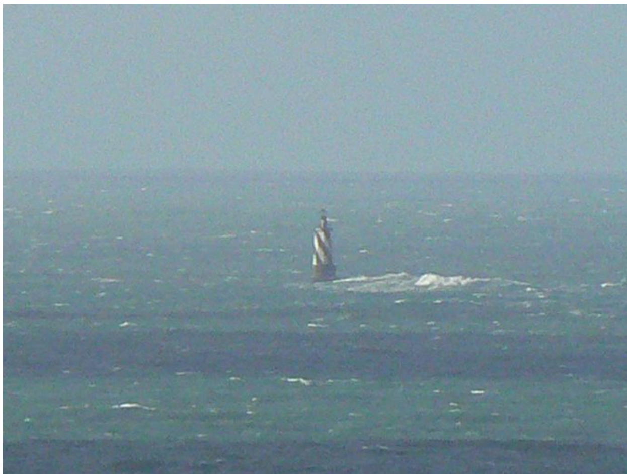
Vue générale de la tourelle de la Parquette
