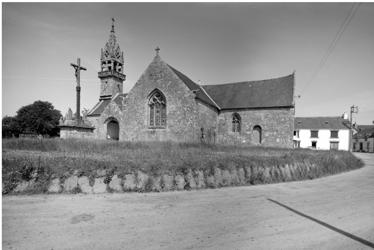
Vue de situation prise du sud est
