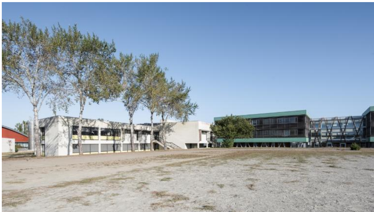
Vue partielle de la façade sud de l'espace sciences (bâtiments B2), Thierry Soquet, architecte, 2015. A gauche, façade est du gymnase.
