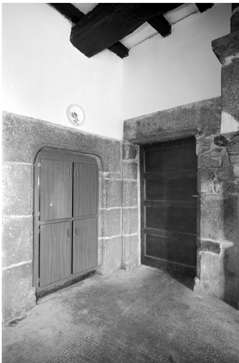
Détail des portes au rez-de-chaussée dans l'angle nord est
