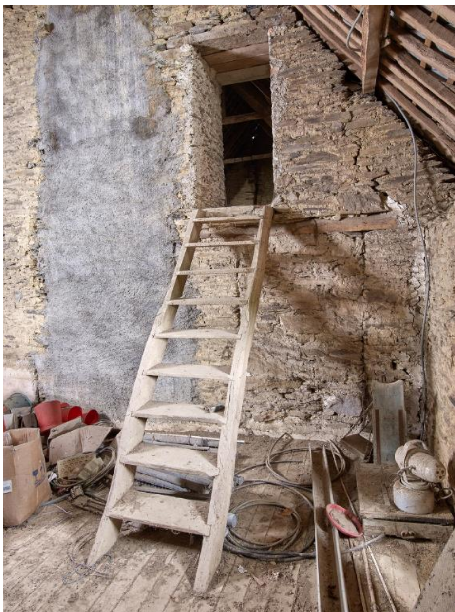
Logis 17e siècle. Haut comble à surcroît. Mur de refend et porte d'accès au comble surmontant la chambre à feu
