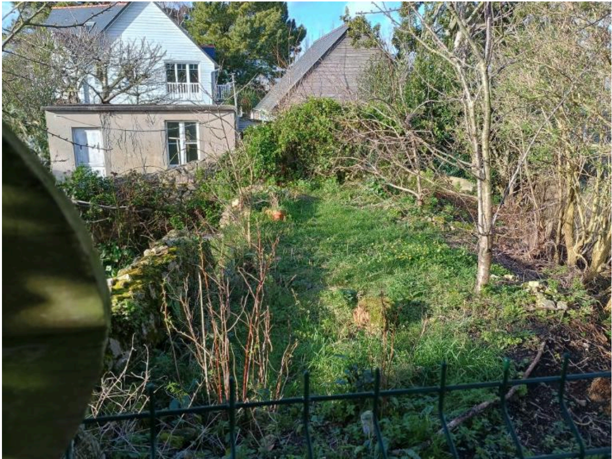
Vue des vestiges de la digue dans la parcelle section CA, n° 558 depuis la parcelle CA, n° 557
