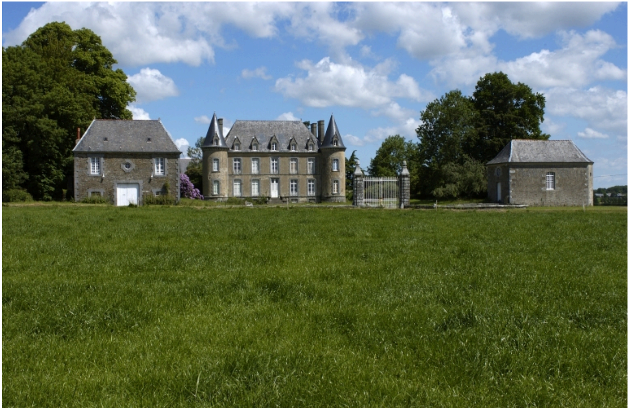
Vue générale sud
