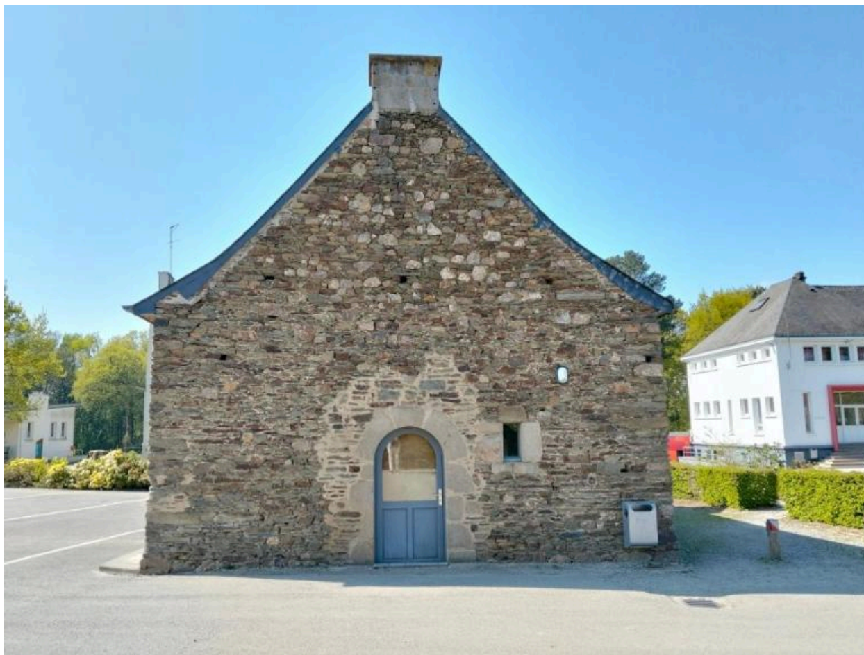
Pignon est, détail
