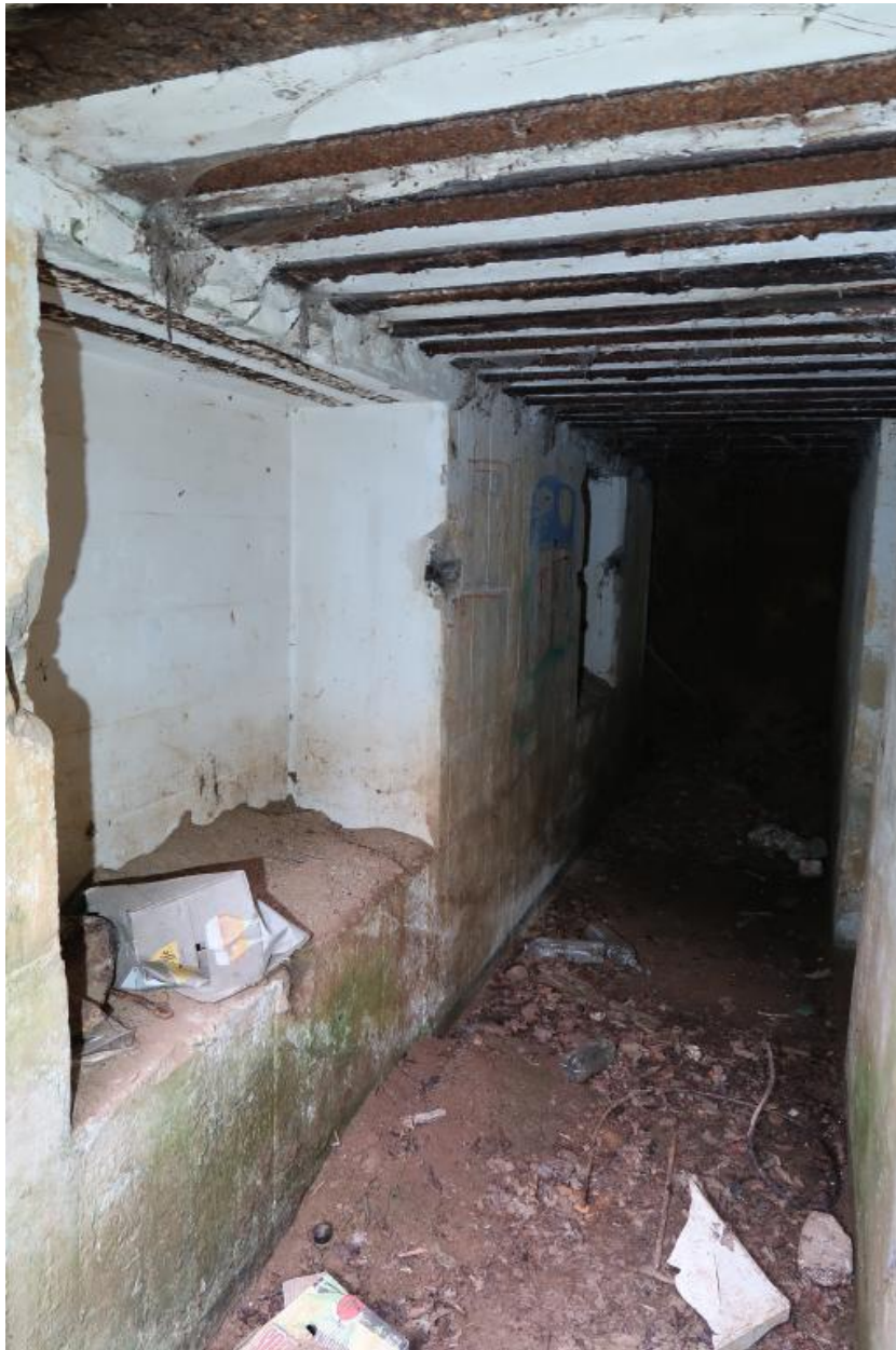
Vue du couloir d'accès depuis l'entrée est (état en 2021). A gauche, niche murale
