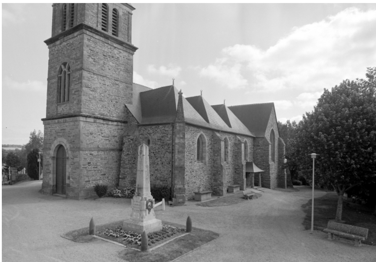
Elévation Sud : vue générale
