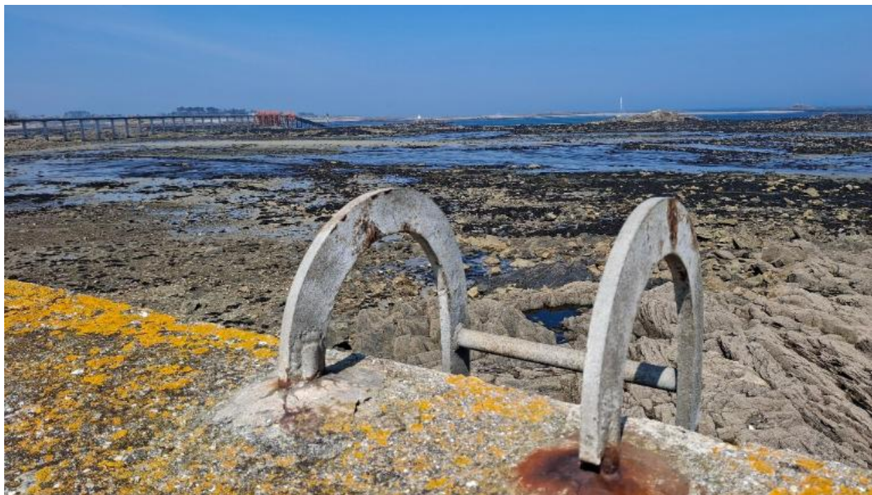
Vue générale de l'estacade et de la zone de navigation depuis le quai neuf
