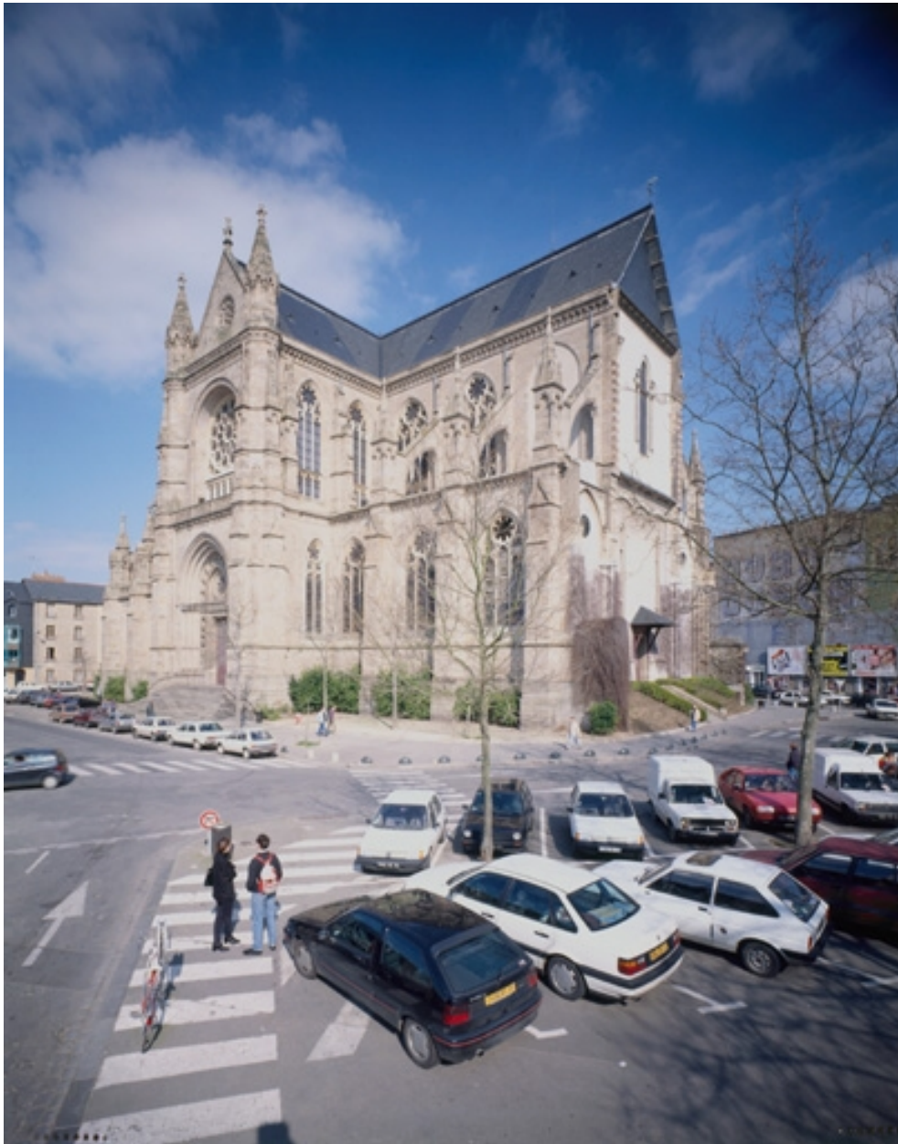
Elévation sud ouest : vue générale
